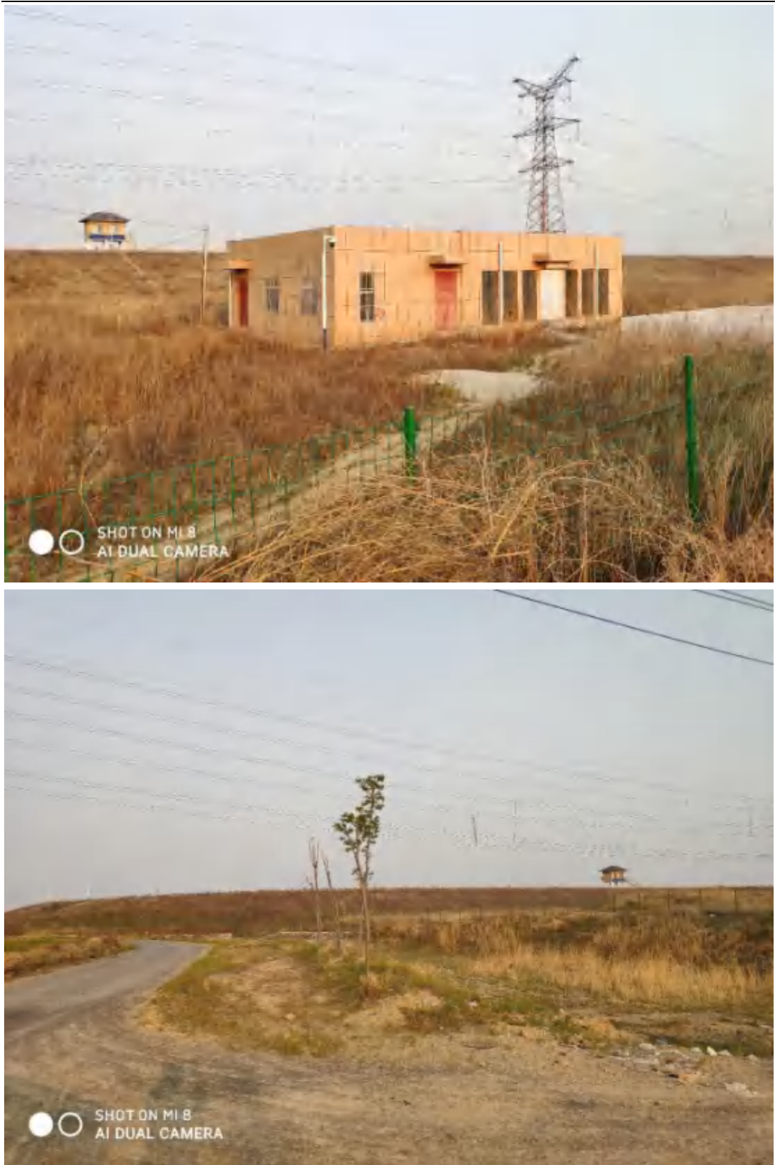
图 2.2-15 潍北二库入库闸
