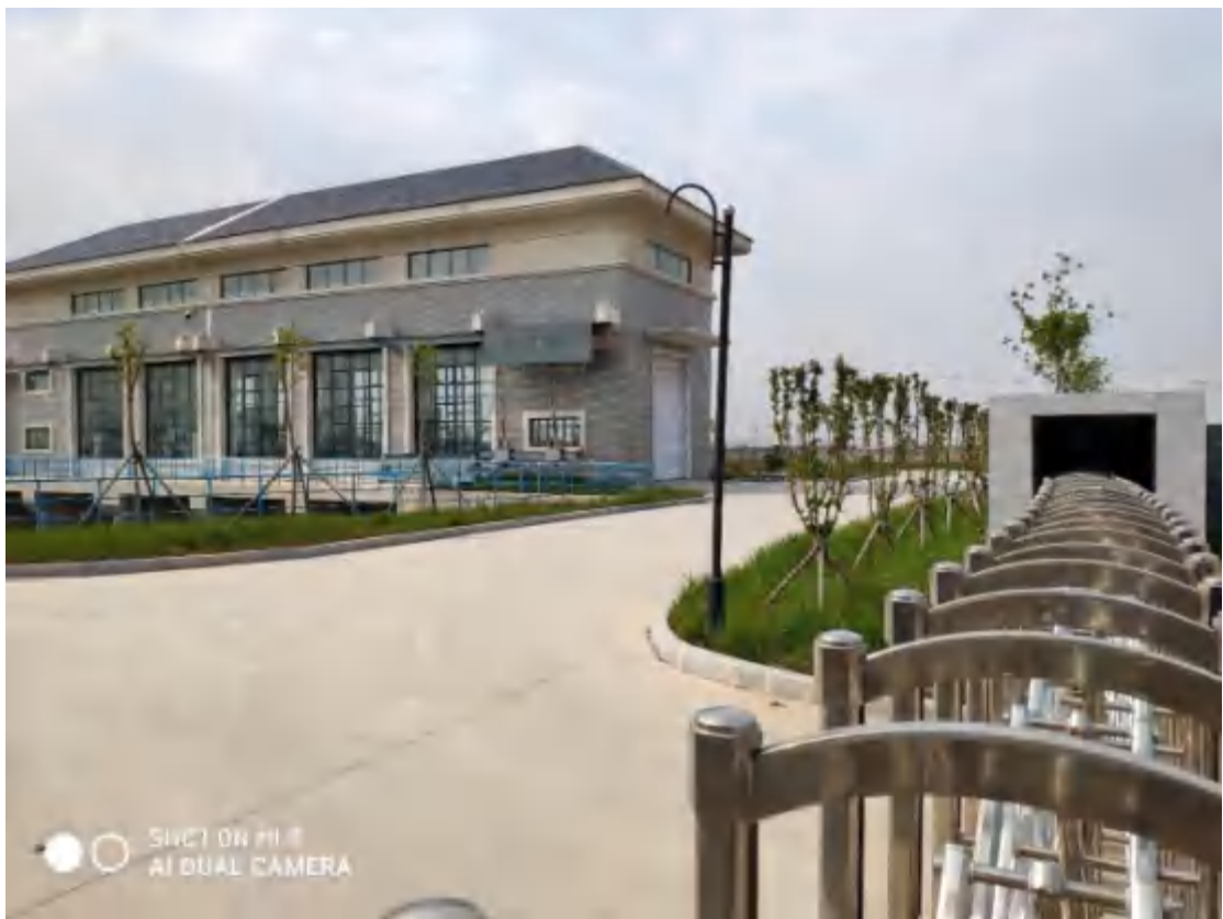
图 5.2-11 麻湾入沉砂池泵站绿化情况
