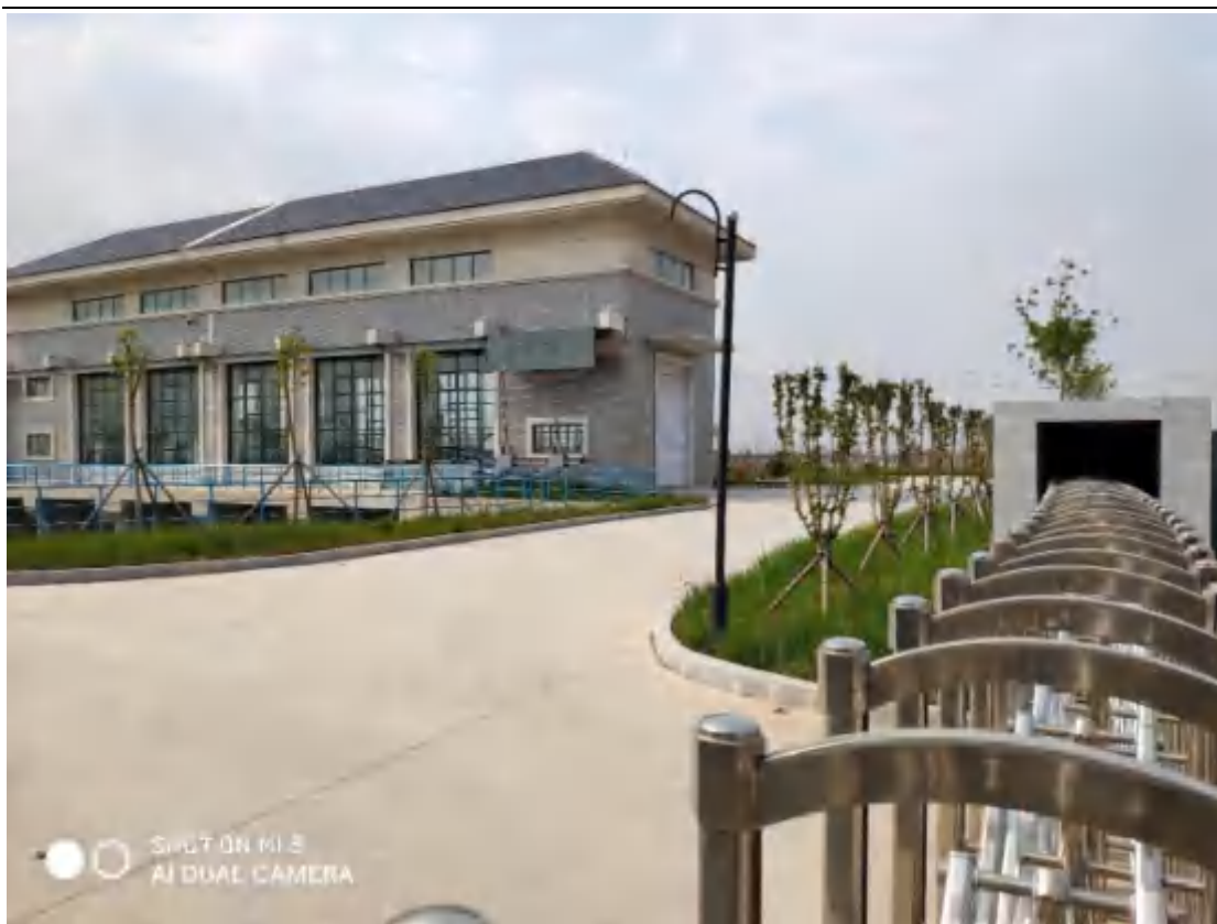
图 2.2-7 麻湾入沉沙池泵站
