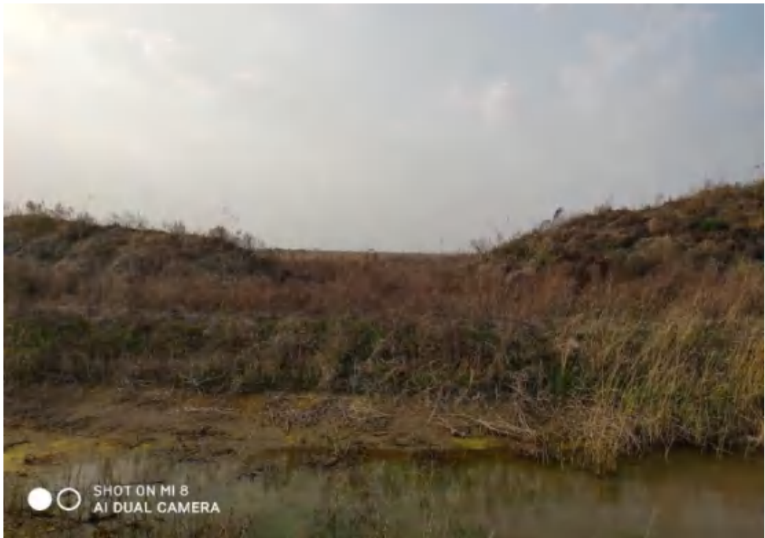
图 5.2-16 顶管施工穿河道恢复情况
