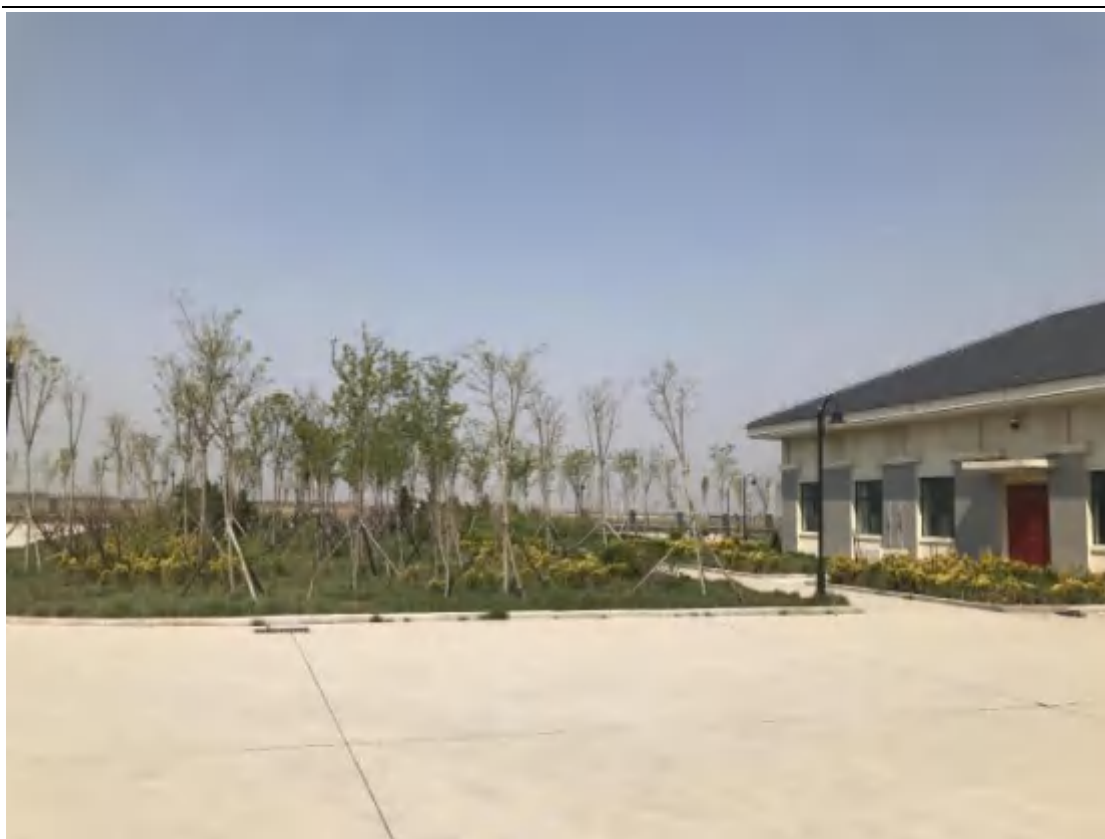
图 2.2-6 曹店入沉沙池泵站
