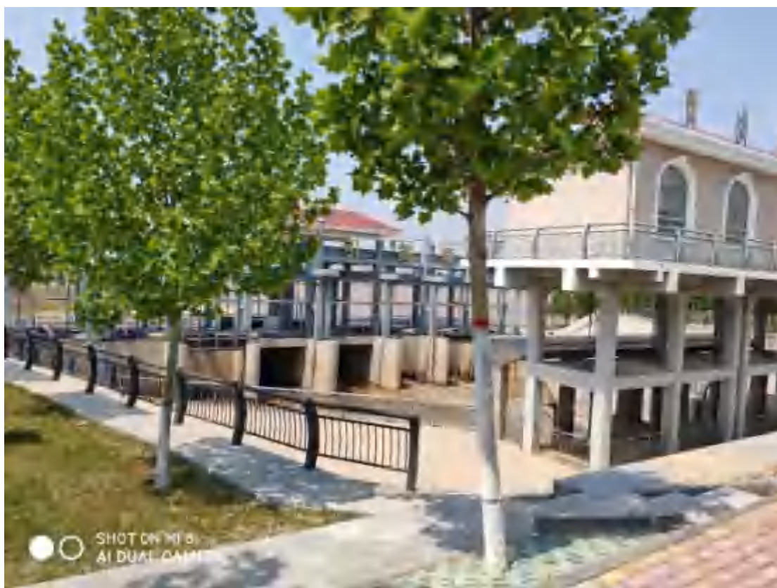
图 2.2-3 曹店引黄泵站
