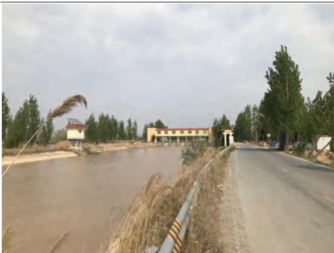
图 2.2-5 麻湾干渠及相关建筑物
